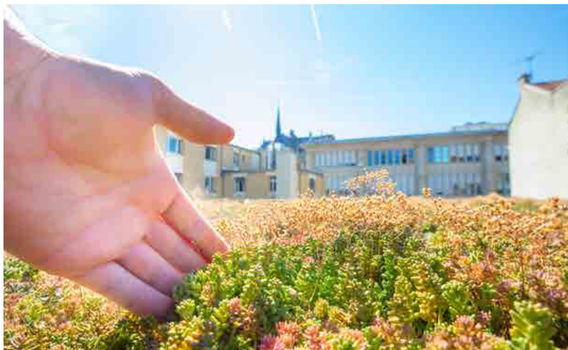
Le couvert végétal composé de plantes rases, type sedum, sur 400 m 2 diminue l'effet d'îlots de chaleur.
