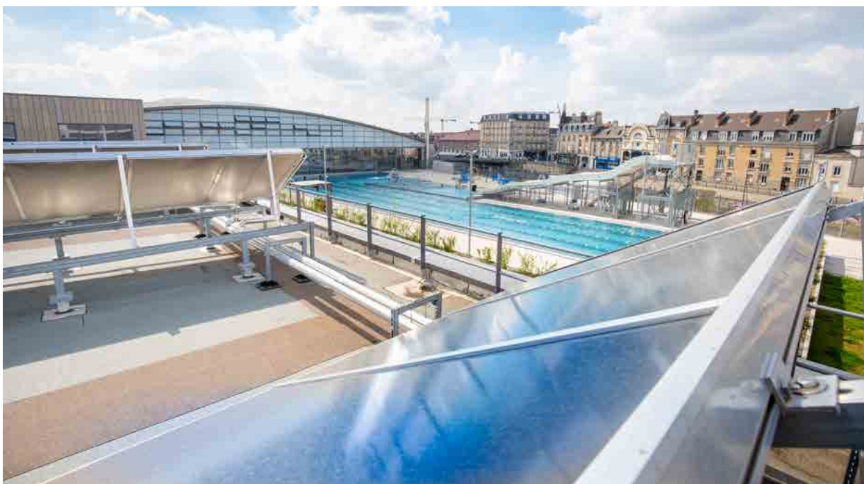
40 % de l'énergie du complexe aqua ludique est issue d'énergies renouvelables (ici des panneaux photovoltaïques)
